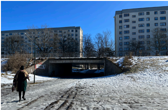
Gångtunnel under Ålgrytevägen
